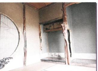
茶室は、大きな円窓を設けて陰陽を表現し、土壁に反故紙(ほごがみ)を貼って詫びを表すなど、伝統の中にも施主の工夫や拘りが感じられる草庵風の茶室です。三又に分かれた3本の柱の変木が特徴で、自然の美しさを表現しています。亀の彫り物や欄間の彫刻は買付けたものと考えられ、部屋のコンセプトに合わせて美しく配置されています。
