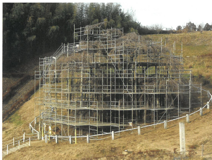
樹勢回復工事のため足場で覆われた滝桜
